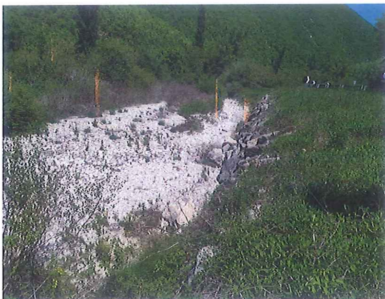
Fig. 15: Fiume Corno - Ripristino scogliera in dx idraulica in comune di Cascia al km. 9,200
